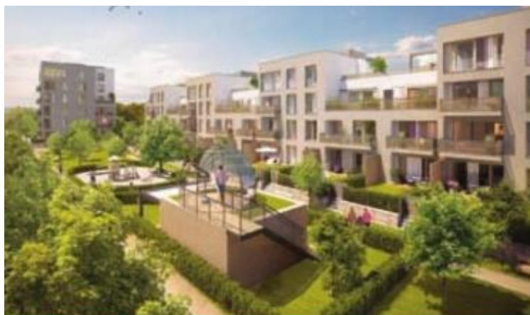
Energeticky pasivní projekt Na hvězdárně Třebešín v Praze 10
