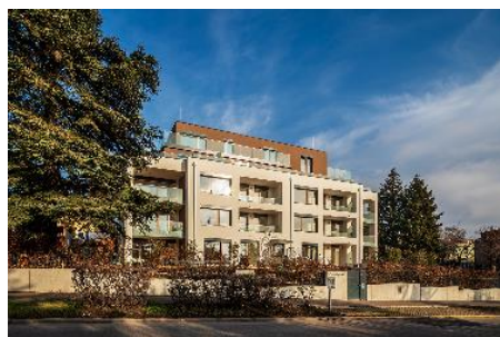
Energeticky pasivní projekt JRD Rezidence Červený dvůr využívá automatický systém řízeného větrání s rekuperací tepla
