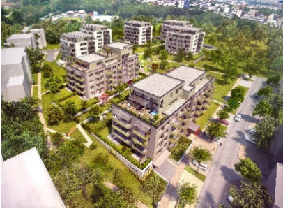
Energeticky pasivní rezidenční komplex JRD Ecocity Malešice
